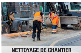
NETTOYAGE DE CHANTIER
