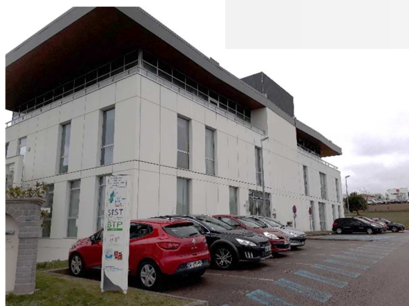
Pôle régional du Bâtiment et des Travaux Publics- AMCO BTP Limoges.
